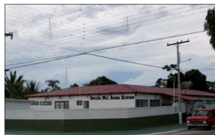
Escola Municipal Boas Novas: totalmente reformada e ampliada
